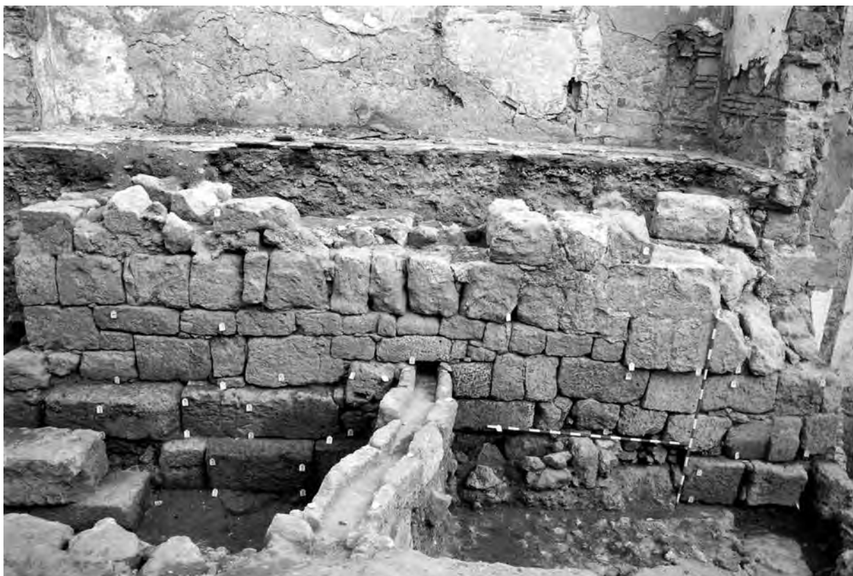
Figura 4. Refectio del siglo VI del tramo este de la muralla (calle Alfonso XIII) (en el ángulo inferior derecho) (foto: N. López).
